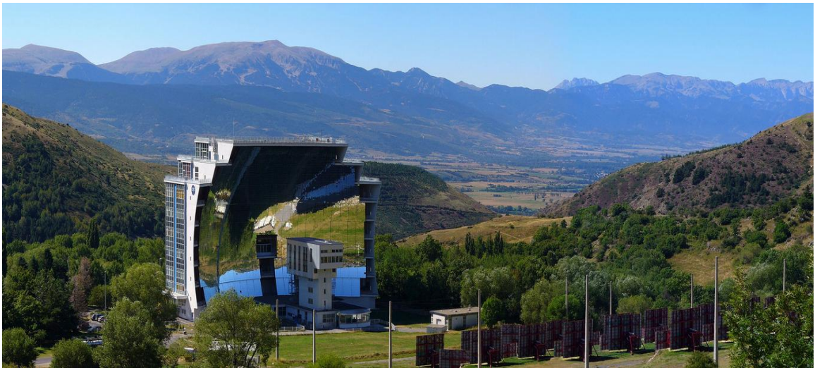
Fig. 2.2 Cuptorul solar MWSF- Centrul Național de Cercetare Științifică "Procedee, Materiale și Energie Solară" (CNRS -PROMES) din localitatea Font-Romeu-Odeillo (Franța) [124].
