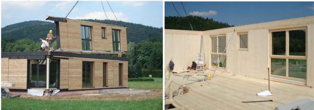
Figura 2.4.1: CLT în varianta prefabricată cu izolare termică, ferestre și fațadă (stânga); Același exemplu la interior cu suprafața pereților finisată la vedere (dreapta)[Paulitsch&Barbu, 2015 după Binderholz]
