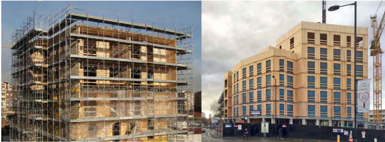
Figura 2.4.3: Construcții multietajate din CLT în Viena (stânga)[ProHolz Austria] și Londra-Hackney (dreapta)[Bauhandwerk]
