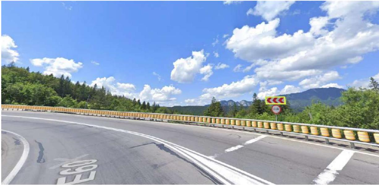
Figure 21. Rolling barrier [28].
